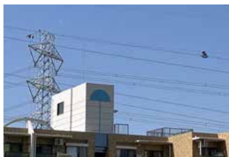
送電線の高所作業中
